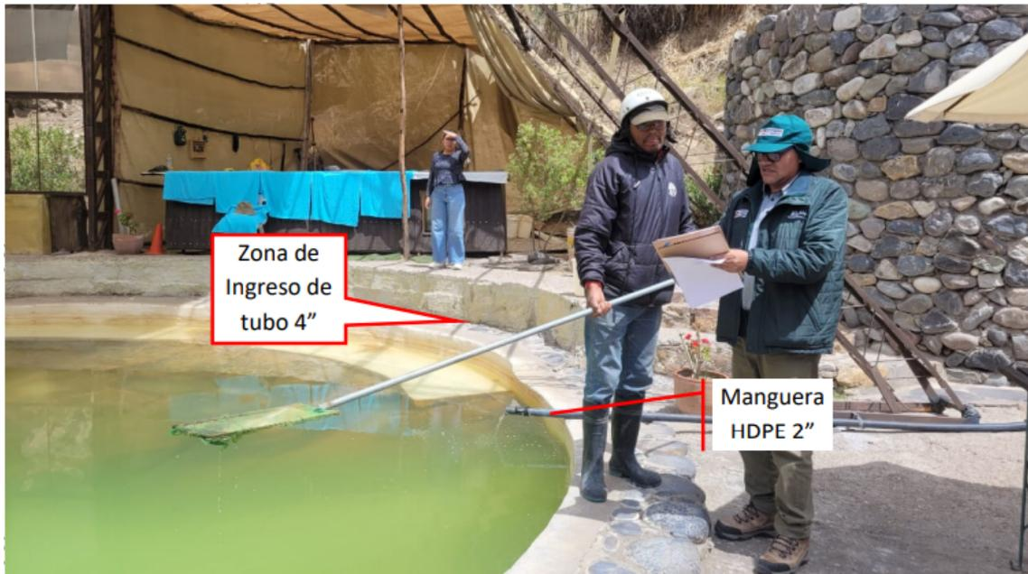
**Imagen 2:** Piscina circular abastecido con tubo de 4" y manguera de 2". <sup>2</sup>
