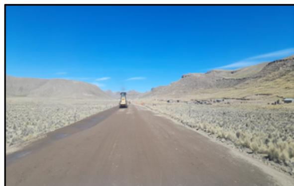
Vista fotográfica N° 10: Se observa al tractor compactadora empleado en la obra para el riego de vía y camino de acceso a la obra.
