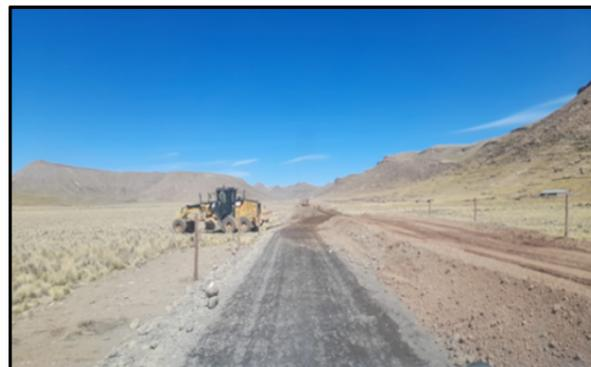
Vista fotográfica N° 07: Se observa el uso del agua para el riego de vía, mediante una cisterna, para el compactado de la capa y el tractor compactadora.
